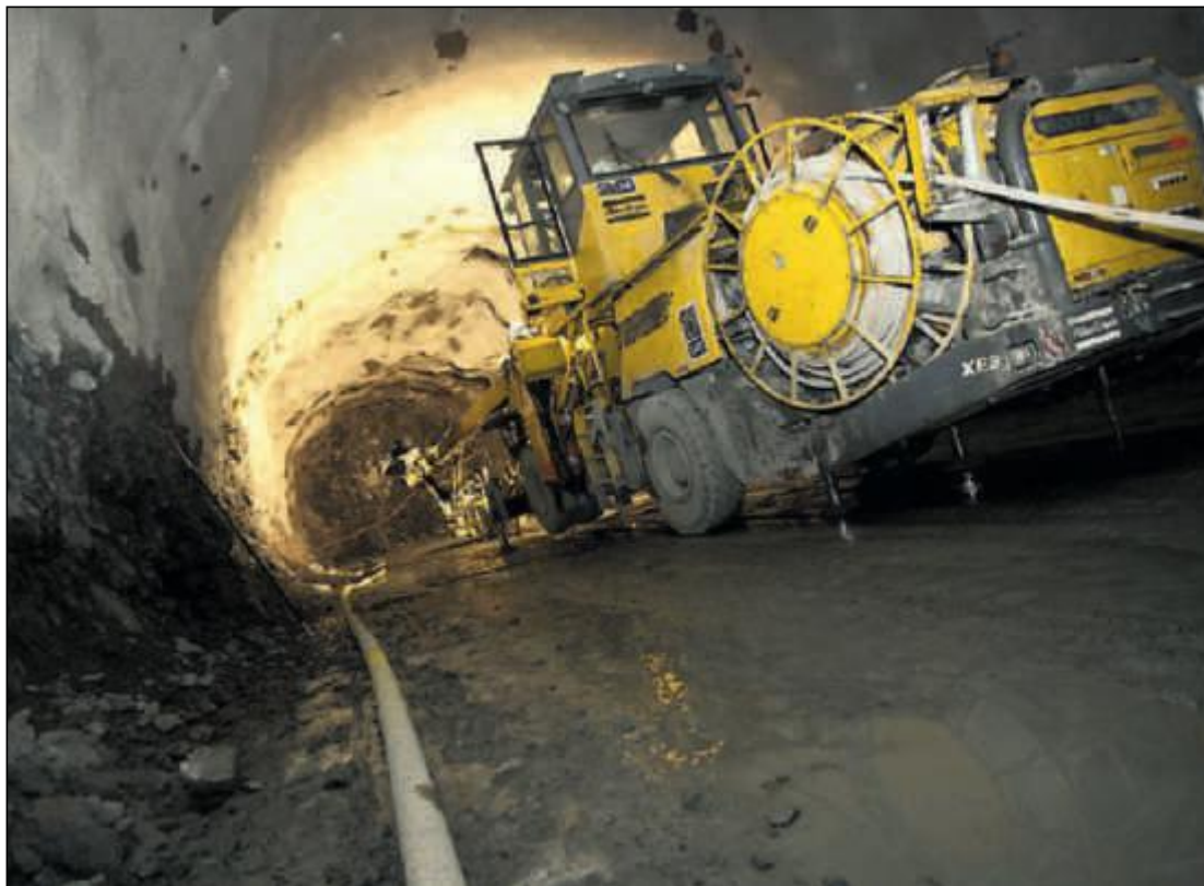
Leonhard Nilsen & Sønner ligger an til å få entreprisen på Hjartåberg-tunnelen på Sunnmøre. (Foto: Stian Klaussen)
