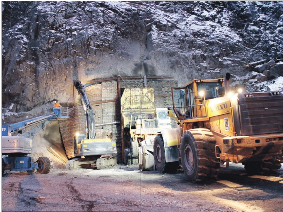
EVENTYRET BEGYNNER FOR ALVOR: Det har for fem minutter siden gått av 250 kilo dynamitt. En ladning som markerer at sprengningen av det 270 meter lange tverrslaget har startet. (Alle foto: Pål Nordby)
